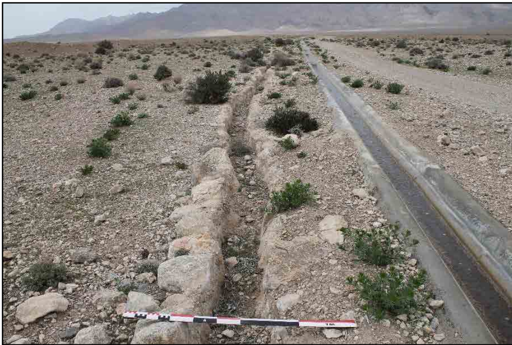
تصویر ۸: مسیر نهر قدیمی و جدید قنات میبذ در کنار هم (نگارندگان ۱۳۹۶). Fig. 8: The route of the old and new Meybod Qanats side by side (Authors, 2017).
